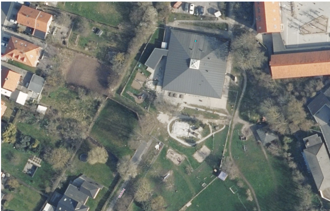
Børnehuset Mælkevejen, Parkvej 20, 4760 Vordingborg. Luffoto 2021, NetGis,
